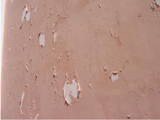
图 3 涂膜起皮剥落
